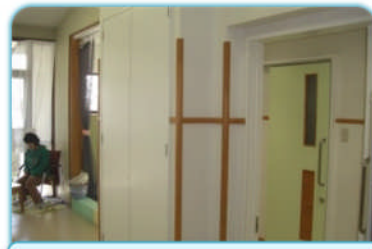
新設された作業室と車いすトイレ
